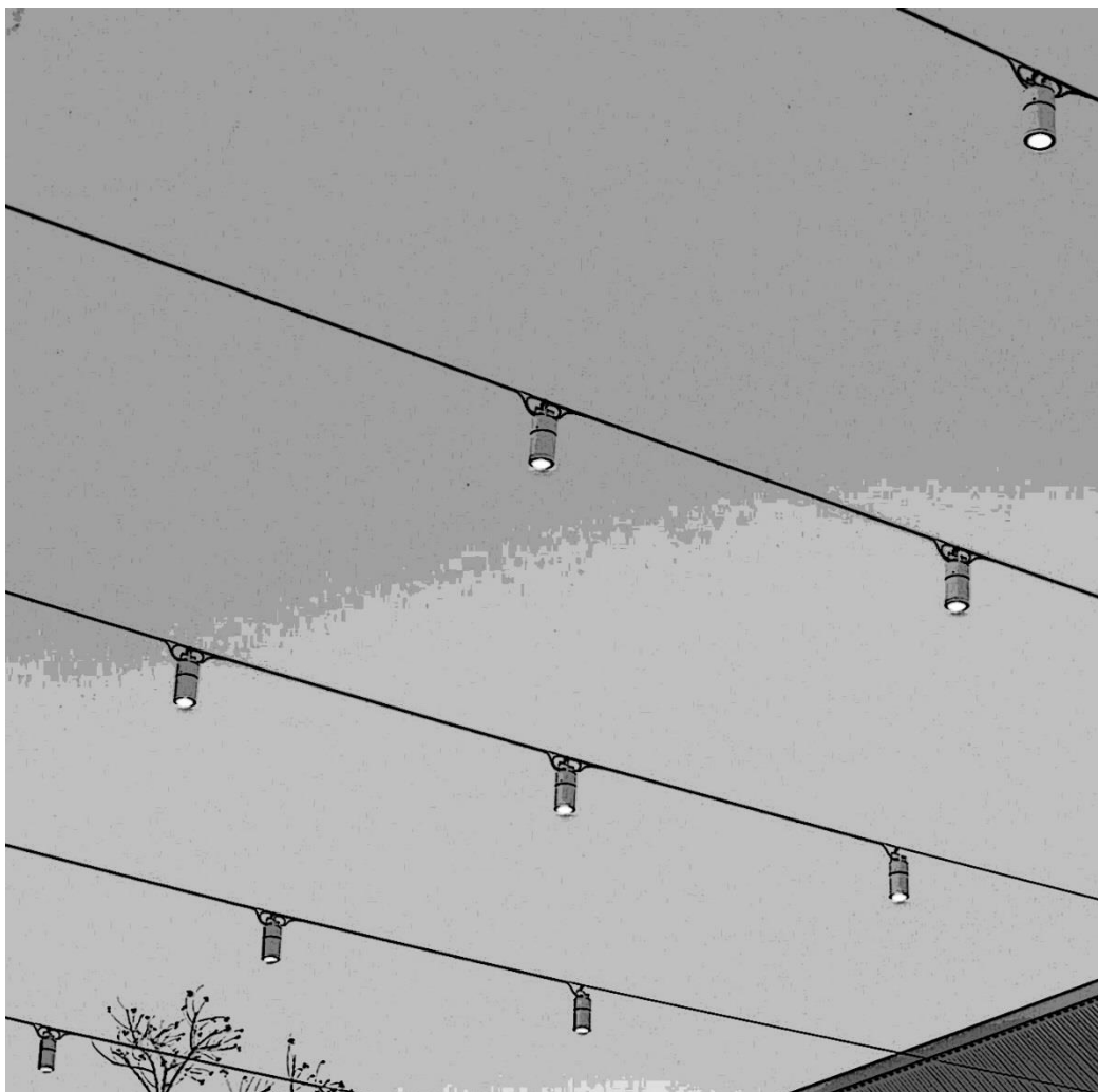
Figur 9.10-6 Exempel på kabelupphängning med sling.
