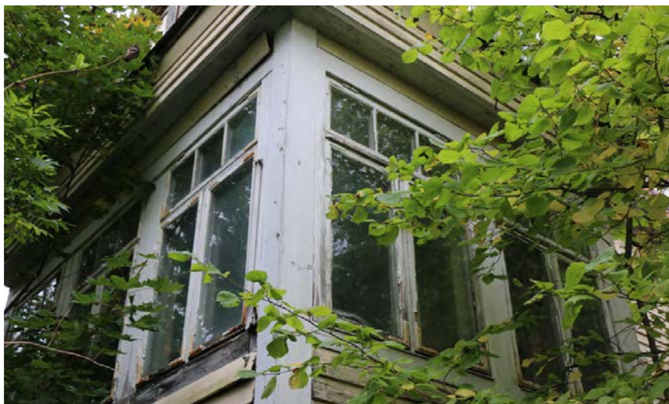
Ursprungliga fönster av jugendkaraktär i glasad veranda.
