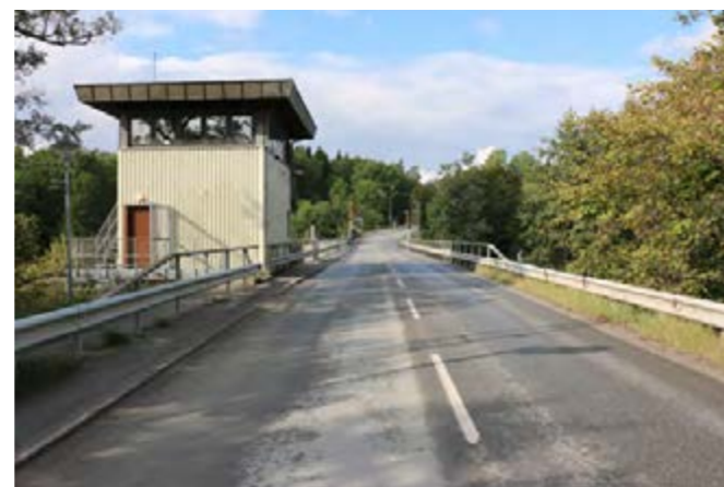
Manöverhus vid landsvägsbron.
