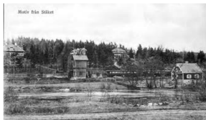
Pensionat Myråsen, Villa Sannaro och Villa Stenröset?. Längst till höger i bild SJ tjänstebostad och i mitten ett rivet vattentorn. Foto: omkring 1920-30, Järfälla kommuns bildarkiv.
