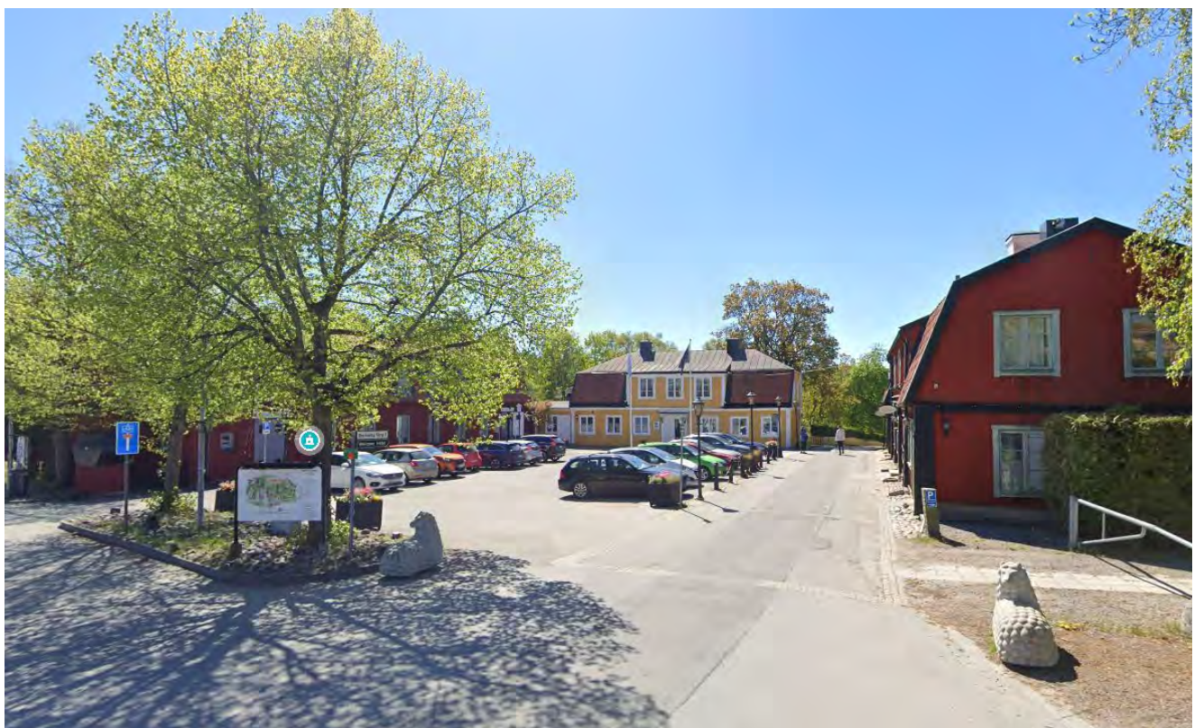
Barkarby torg med Tingshuset och vårdshuset Lasse-Maja samt konferensbyggnaden till vänster
