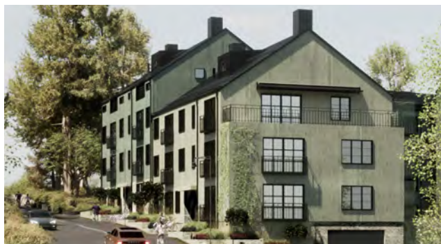
Husens trappning längs Enköpingsvägen
