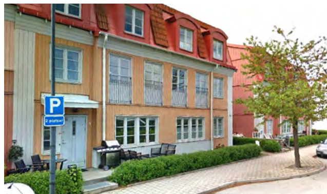
Förgårdsmark vid Fransborg (flerbostadshus på Häradsvägen)
