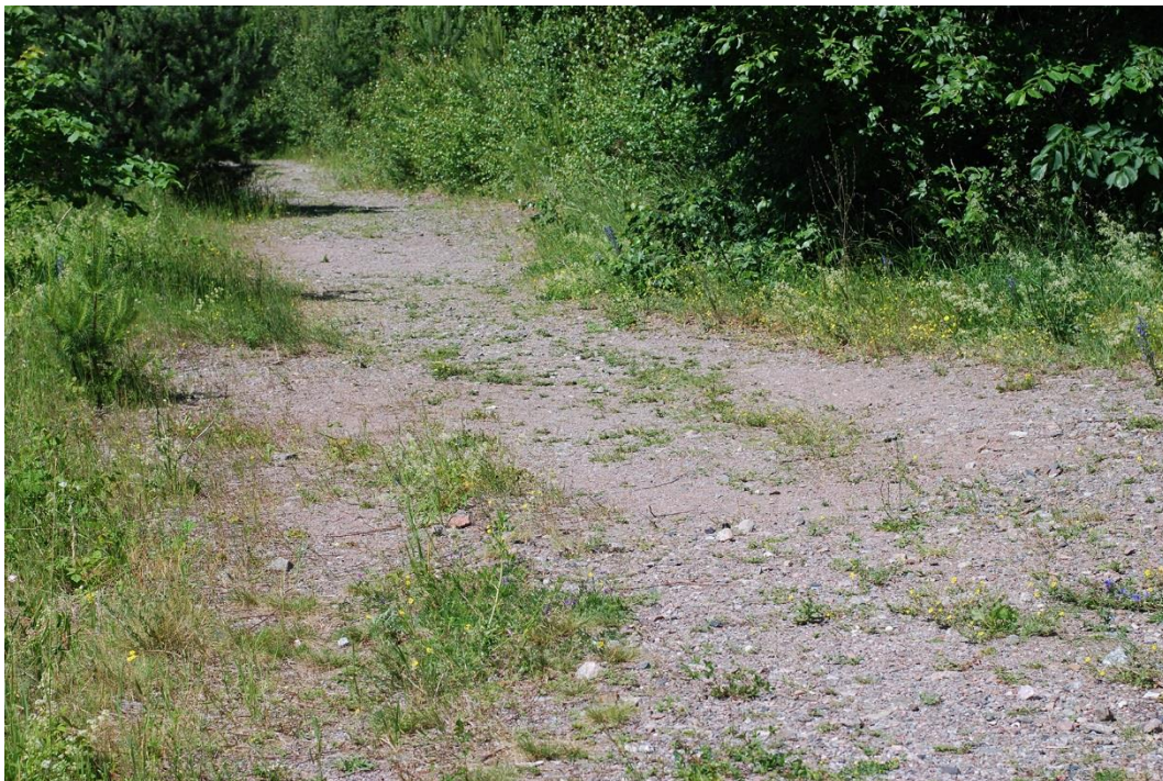
Figur 8. Den gamla banvallen som börjar att växa igen från slänterna. Det finns dock kvar blottade sandiga/grusiga ytor.
