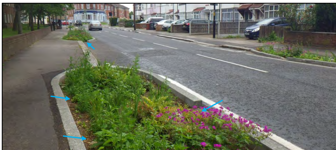
Figur 17. Exempel på nedsänkta regnbäddar placerade mellan angöringsplatser längs en gata. Transport av dagvatten från gatan sker via släpp i kantsten och från gång- och cykelväg via ytlig avrinning. Regnbäddar i gata förses även med träd.
