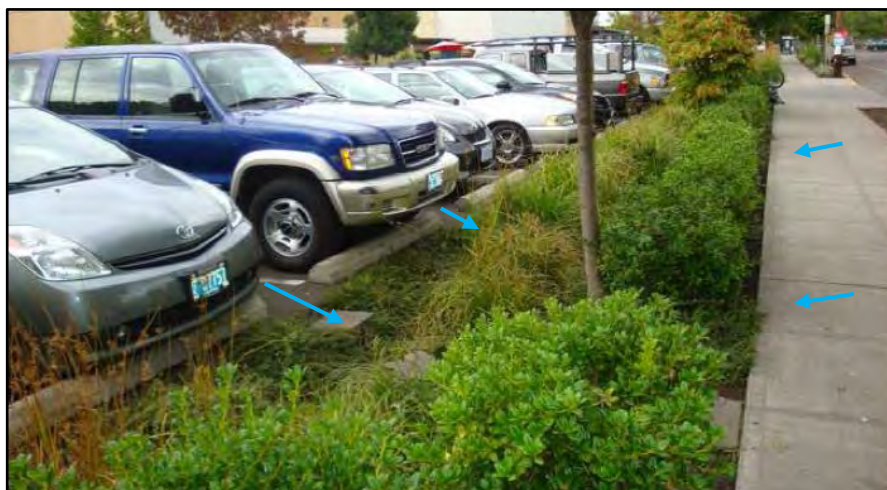
Figur 13. Exempel på parkeringsyta med ytlig avledning av dagvatten till långsgående skålad regnbädd för infiltration och rening. Även gångvägen avleds ytligt till den nedsänkta anläggningen.
