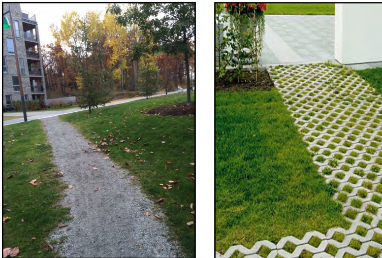
Figur 11. Exempel på genomsläppliga beläggningar. Grusyta i den vänstra bilden och gräsbeklädd markarmering i betong i den högra bilden.
