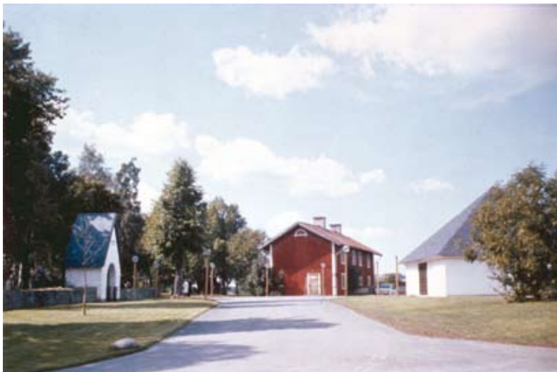
Fattigstugan något eller några år innan den brann ned i december 1975. Norra stigluckan t.v. och bisättningshuset t.h. Foto ur Järfälla kommuns bildarkiv. Fotograf:
