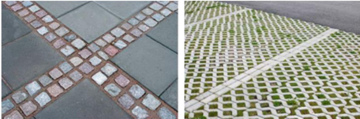
Figur 7-5. Två exempel på genomsläppliga beläggningar, gles plattsättning med sandfog och gräsarmering.
