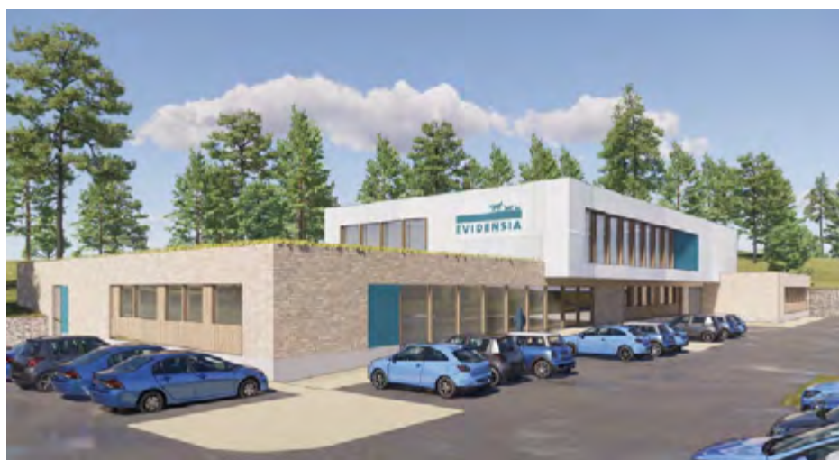
Figur 6: Byggnadsverkets fasadutformning skiljer sig åt mellan bottenvåningen och övervåningen i material och färg men bidrar till ett sammanvägt helhetsintryck. Bild: FOJAB
