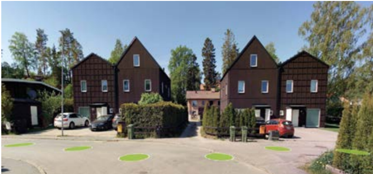
Figur 3: De befintliga parhusen i planområdet, på bilden syns även skaftvägen till Skälby 3:668.
