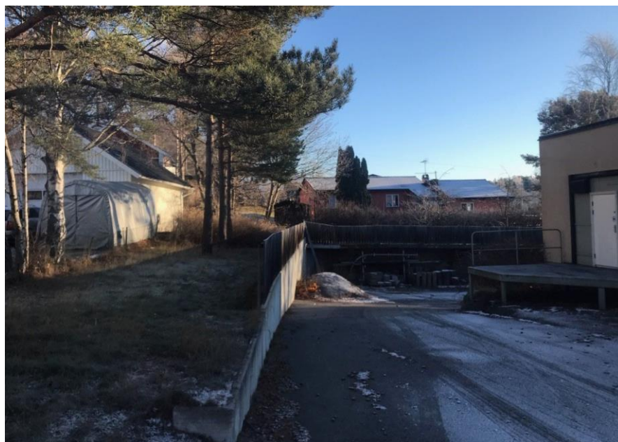
Figur 8. Lokal lågpunkt i nedsänkt lastplats i planområdets nordöstra del. Foto: Jenny Andersson
