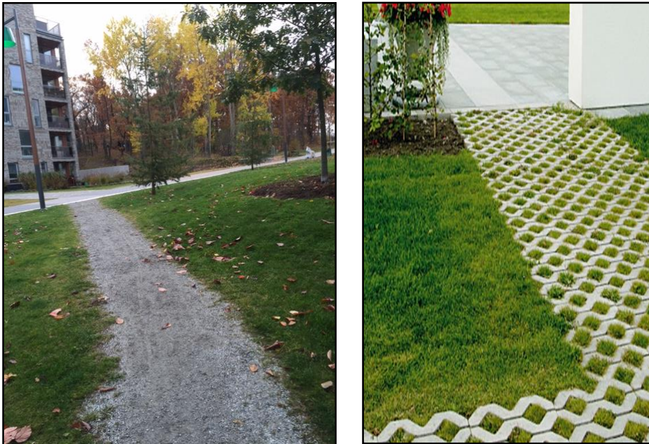
Figur 15. Exempel på genomsläppliga beläggningar. Grusyta i den vänstra bilden och gräsbeklädd markarmering i betong i den högra bilden.
