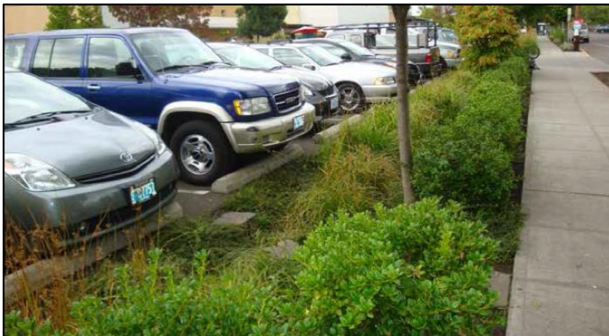
Figur 17. Exempel på parkeringsyta med ytlig avledning av dagvatten till långsgående skålad regnbädd för infiltration och rening. Även gångvägen avleds ytligt till den nedsänkta anläggningen.
