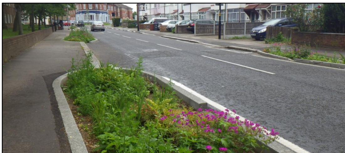
Figur 12. Exempel på nedsänkta regnbäddar placerade mellan angöringsplatser längs en gata. Transport av dagvatten från gatan sker via släpp i kantsten och från gång- och cykelväg via ytlig avrinning.
