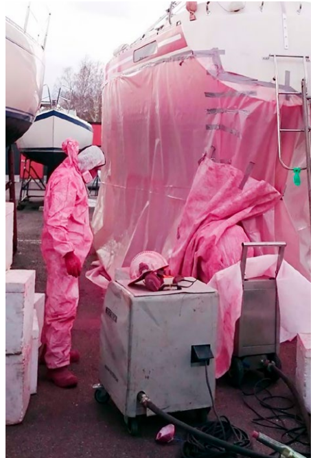
Bilden visar hur en felaktig blästring kan ge upphov till mycket damm som sprids till omgivningen.
