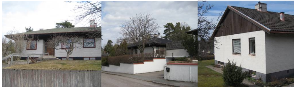
Byggnader i karaktärsområdet "Grupphusen"
