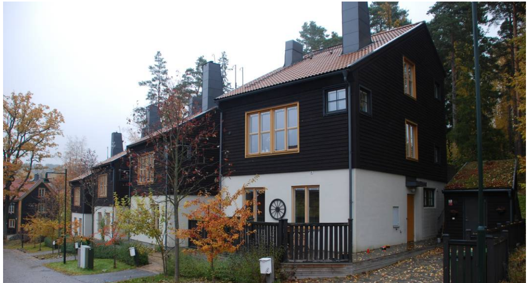
Exempel på sutteränghus, Tullinge, med sedumtak på garage
