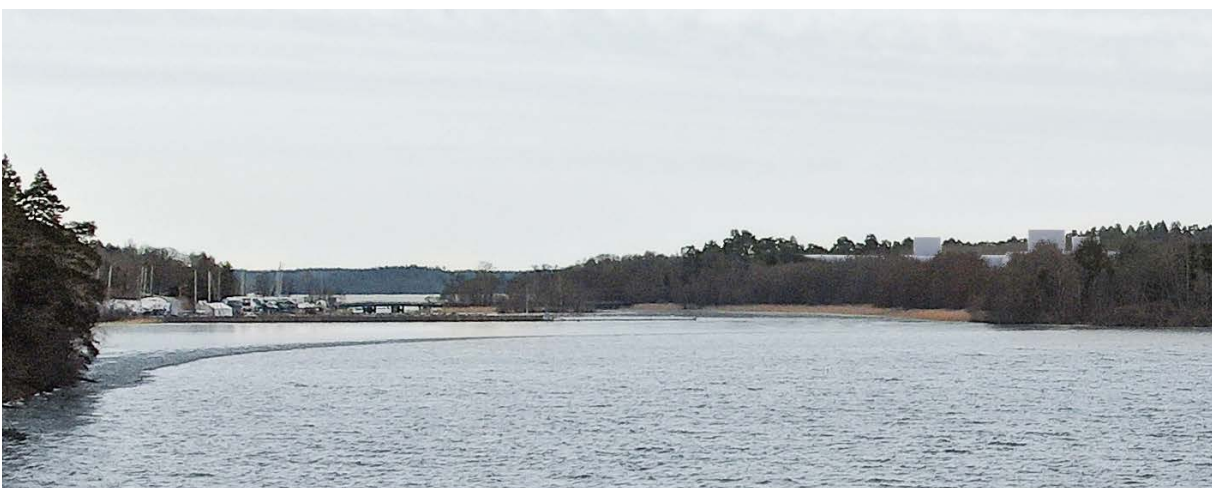
Figur 10: Kompletterande vattenverk sett ifrån Görvälbadet i Järfälla kommun
