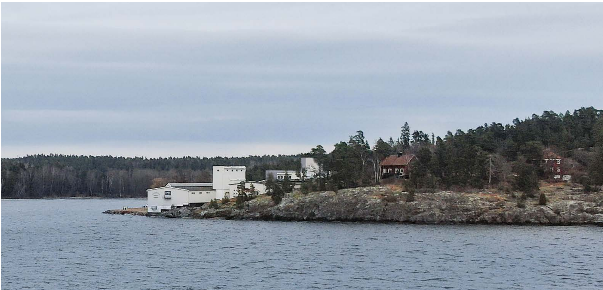
Figur 9: Befintligt och kompletterande vattenverk sett ifrån Väntholmen i Ekerö kommun
