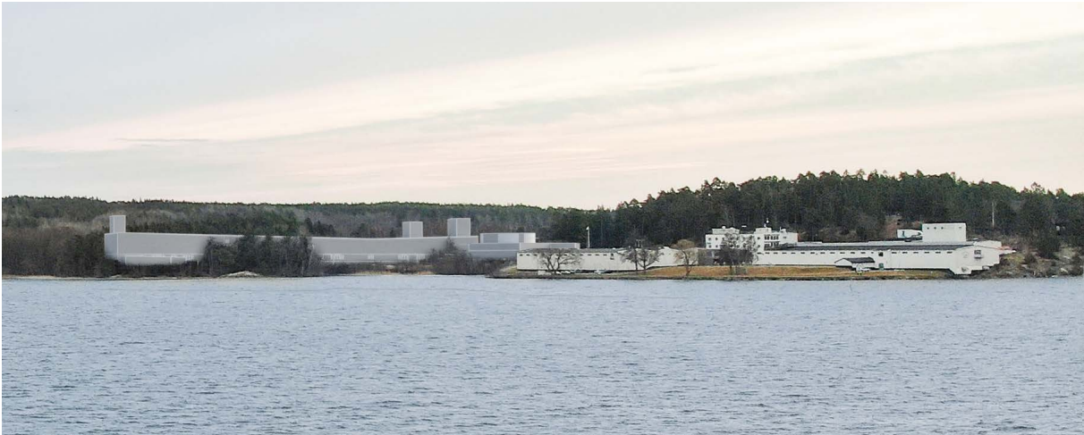
Figur 8: Befintligt och kompletterande vattenverk sett ifrån Allmansöarna i Upplands-Bro kommun
