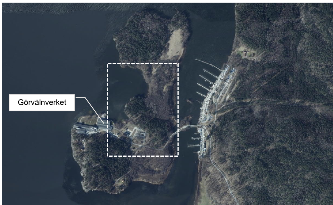
Figur 1. Aktuellt område för geoteknisk utredning inom streckad linje. Befintliga vattenverket, Görvålverket, ligger i sydvästra delen av området.
