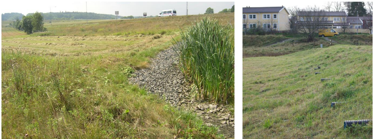
Figur 15. Två exempel på översilningsyta (SVOA). Vänstra bilden visar en översilningsyta där vatten fördelas via ett makadamlager medan den högra bilden fördelar vatten via rörledningar från ett bostadsområde. Den högra är inte att rekommendera med synliga ej tillsågade plaströr, den visas mer för att visa principen.
