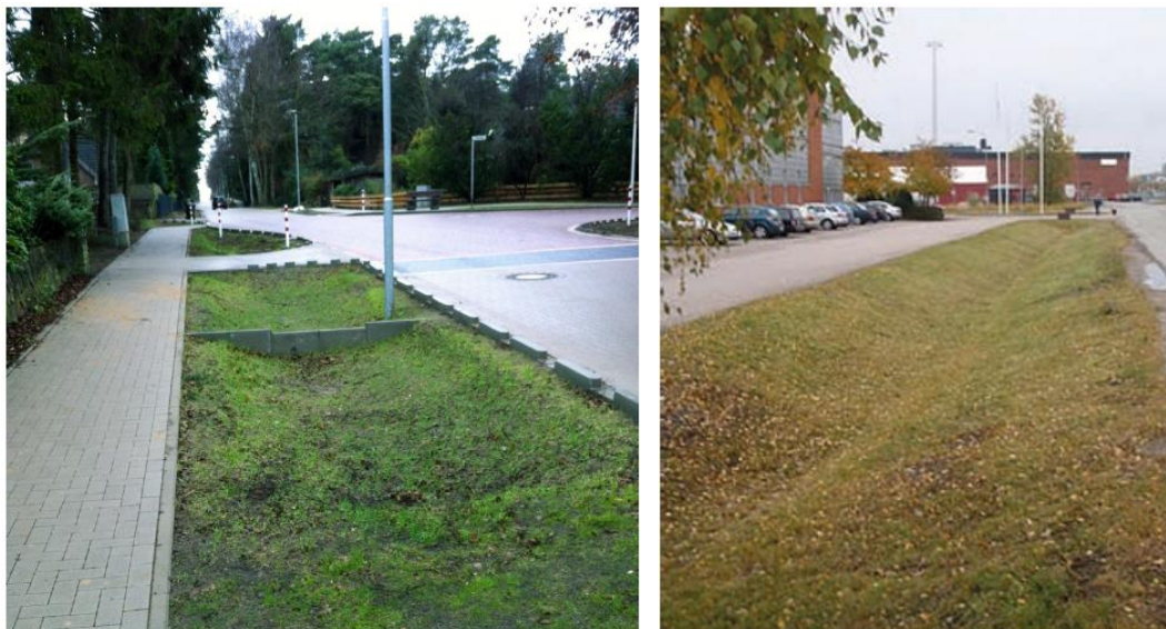
Figur 13: Två exempel på infiltrationsstråk (SVOA). Vänstra bilden visar ett sektionerat dike/infiltrationsstråk.
