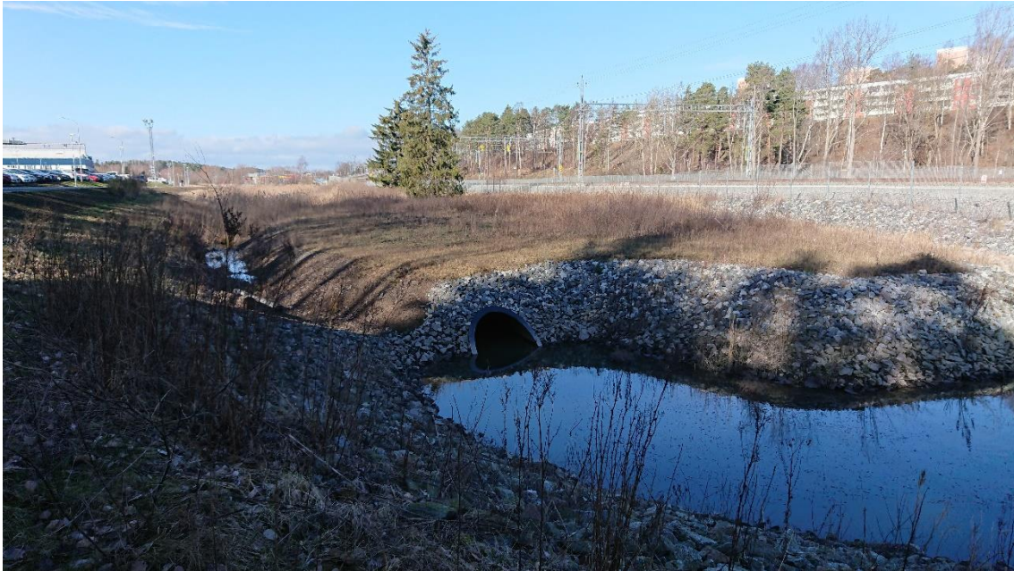
Figur 5. Tryckbank med Bällstaån i kulvert, Mälarbanan till höger i bild och Bällstadalen till vänster i bild, foto taget 2020-03-09
