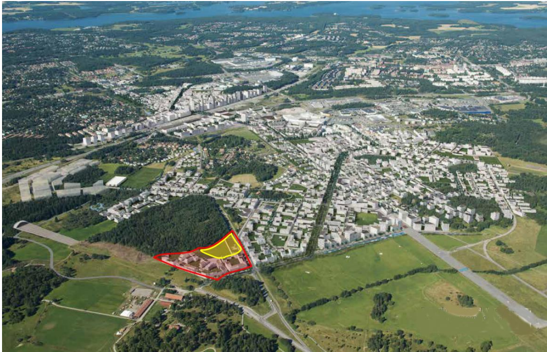
Figur 2. Strukturen för Barkarbystaden utritad på flygfoto. Det föreslagna planområdet kommer utgöra en entré till Barkarbystaden och därför bör gestaltningen av fördelningsstationen ges betydelse vid planläggningen. Väster om planområdet syns skogsområdet Hästa klack.
