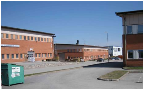
Befintliga industribyggnader intill Runstenstenvägen
