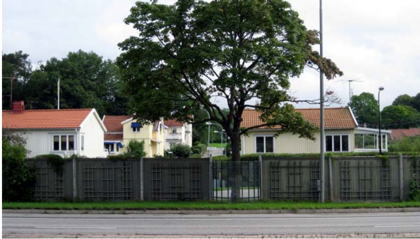
Exempel på utformning av bullerskärm där träd är planterade i linje med bullerskärmen
