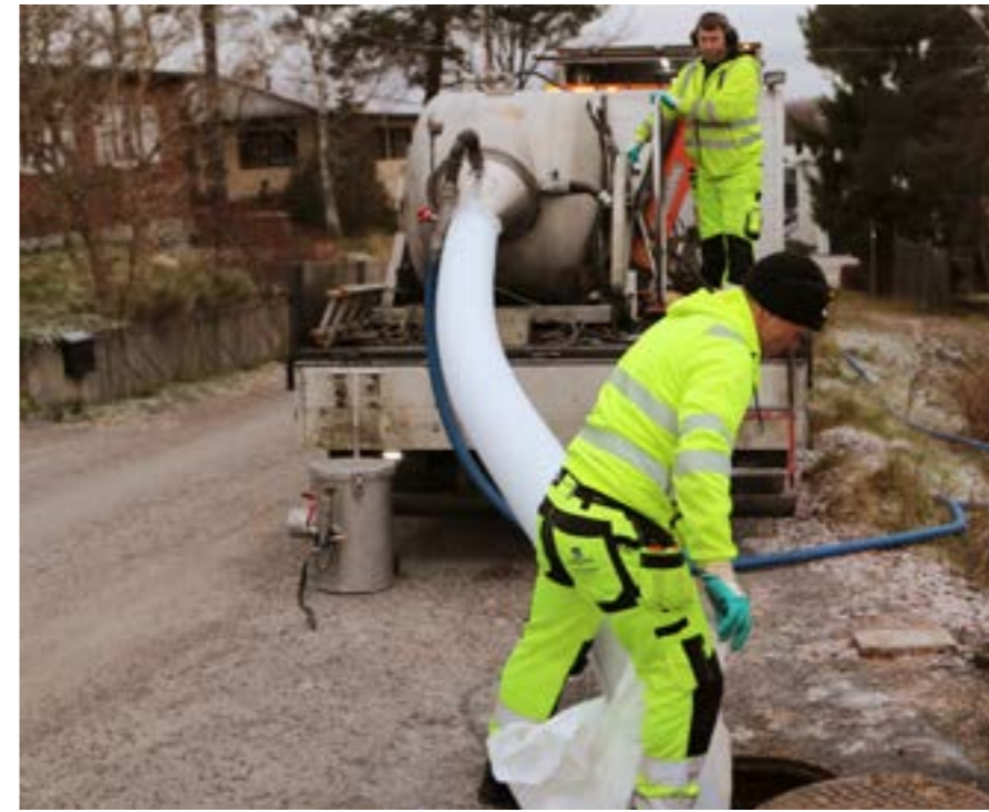
Den vita plastmassan skjuts ner i de gamla röret för att skapa nya rör.
