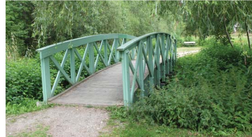
GÅNGBRO ÖVER VATTENDRAGET
