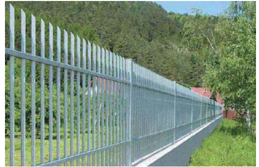
Exempel på pallisadstaket på sockel
