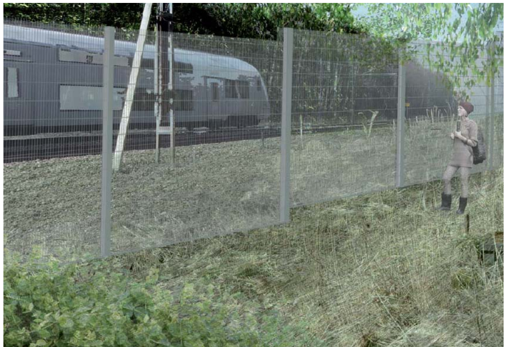
Exempel på 2,5 meter högt svetsat trådstängsel
