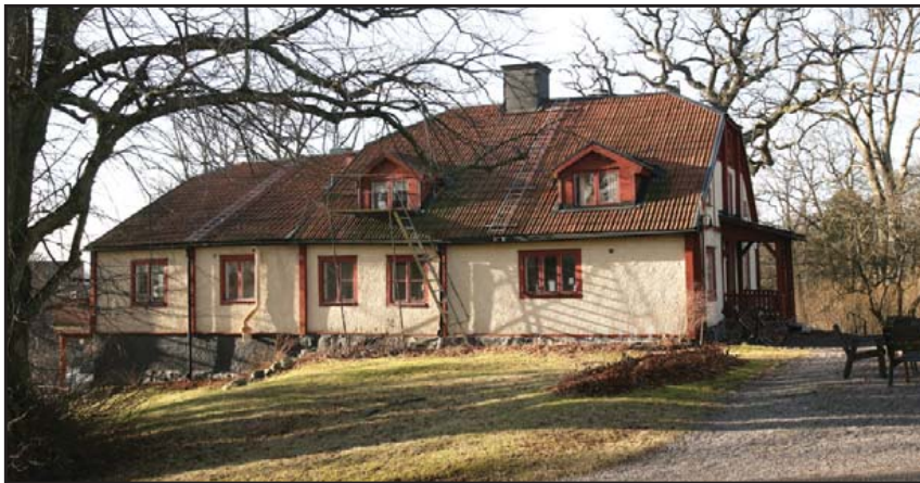
Södra flygeln på Jakobsbergs gård
